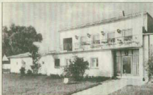
So sah das Clubhaus nach der Fertigstellung 1959 aus. Foto: ERC
